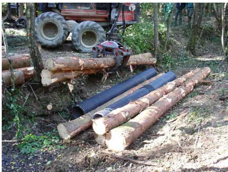
Fig. 13 : Mise en place du dispositif de franchissement
