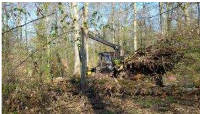
Façonnage au grappin-scie du houppier
