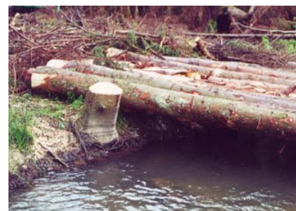
Le pont de bois (source FCBA)
