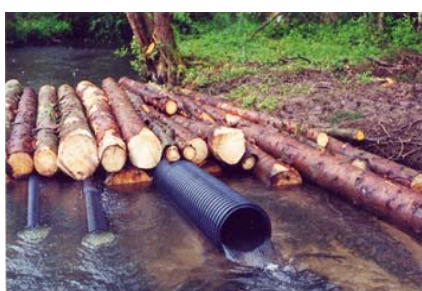
Les tubes de type PEHD (PolyEthylène à Haute Densité) avec rondins (6 kits recensés par l'enquête) (source FCBA)
