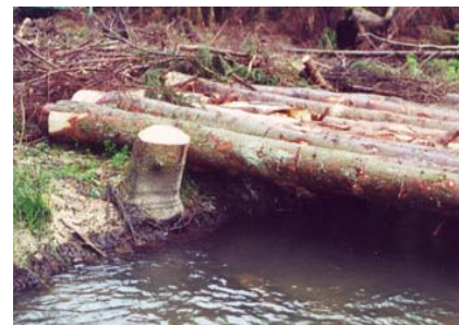
Le pont de bois (source FCBA)
